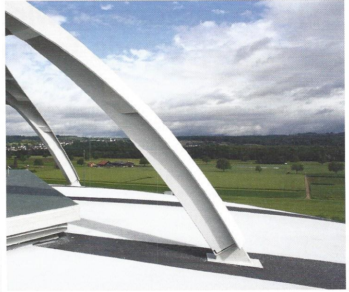
Abdichtungs-Anschlüsse an den Bauteilen sind mit Flüssigkunststoff detailgenau und rasch realisierbar.
