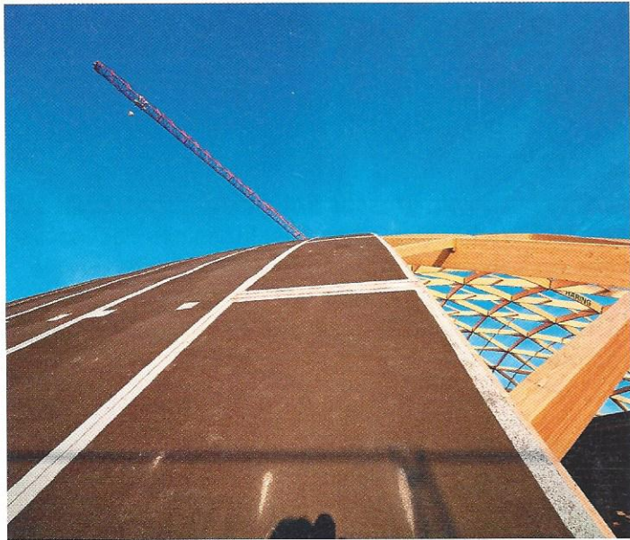
Eingebaute Dachelemente: Nur die Abdichtung der Stossfugen sowie die Ausführung von An- und Abschlüssen erfolgte vor Ort.
