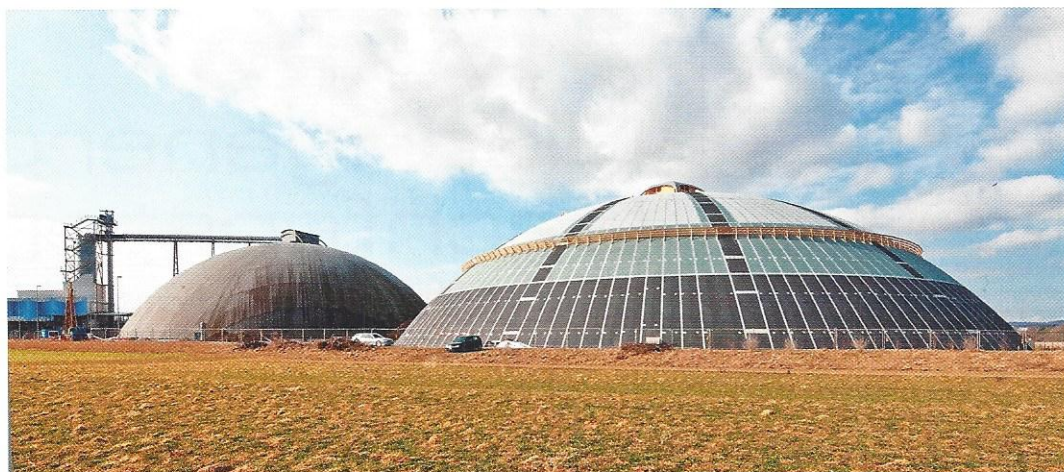
Der neue Saldome 2 – rechts neben Saldome 1 – besticht durch die Abmessung und Form einer Kugelkalotte von 120 m Durchmesser. Das 32,5 m hohe Kuppeldach wurde mit einer modernen PMMA-Flüssigkunststoffbeschichtung der Marke Alsan abgedichtet.
